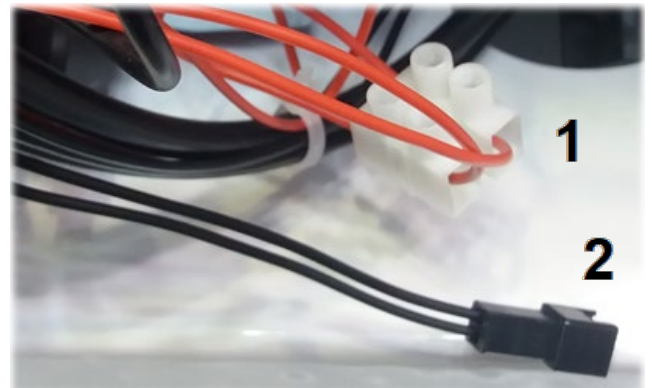
Рис.17 Перемычка комнатного термостата (1), разъем датчика NTC бойлера (2, для котлов «Н»)
